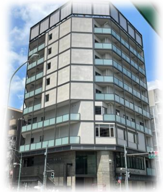
築地本願寺佃ビル外観
